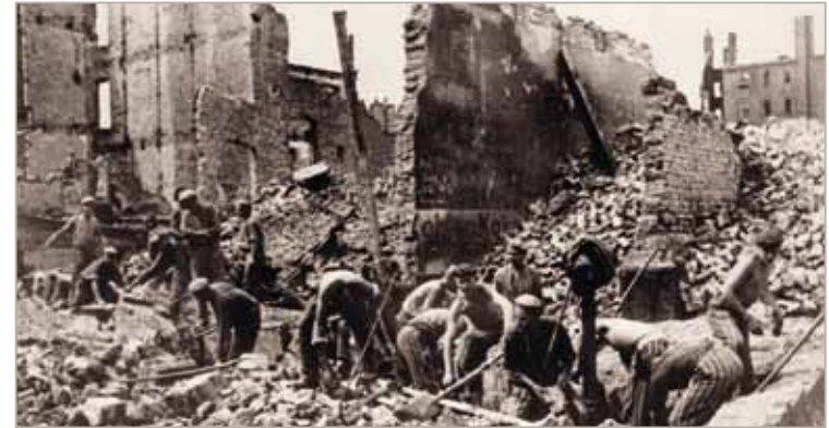
Häftlinge bei Aufräumungsarbeiten in Hamburg-Hammerbrook, 1943. (StA HH)
